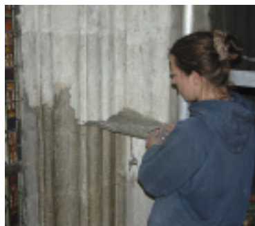
Steinmetzin Sandra Engelhardt beim Reinigen der Steinoberfläche am Marienotfenster mit Latexlasur.
