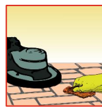
Oberfläche trockenpolieren
