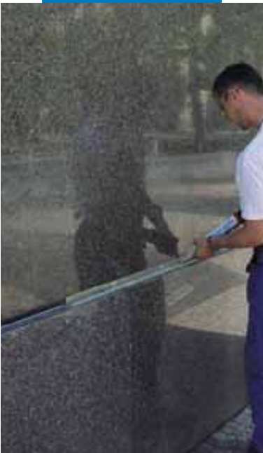
Natursteinverfugung mit Mapesil LM im aussenbereich
