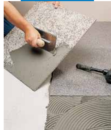
Verlegung von Kunstgranitplatten im Buttering-Floating-Verfahren mit Granirapid-grau
