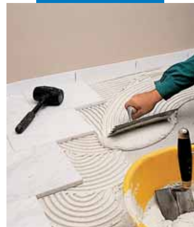
Verlegung von Carrara-Marmor mit Granirapid-weiß
