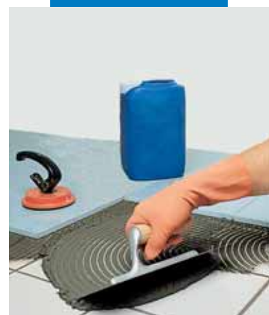
Verlegung von Fliesen auf Fliesen mit Granirapid-grau
