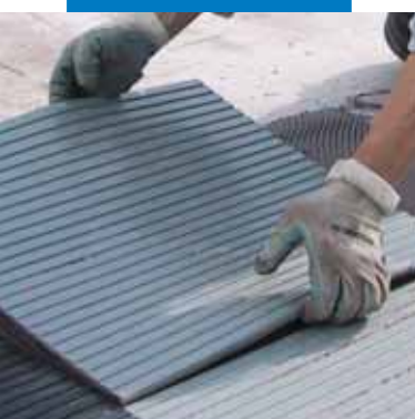
Verlegung von Gummi-Bodenbelagplatten mit Granirapid
