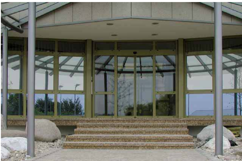
Fachgerecht ausgeführte Außentreppe aus Naturwerkstein
