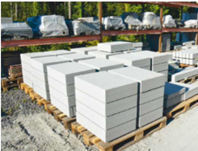
Massive Sandsteinplatten, die bei der Sanierung der Stadtmauer von Radolfzell zur Erhöhung der Mauerkrone eingesetzt werden sollen.
