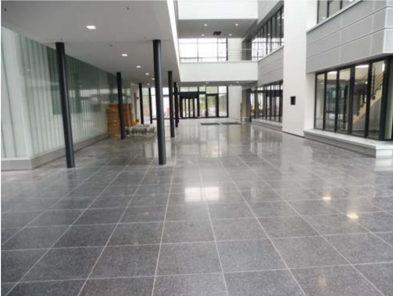
Halle mit 60x60x3cm Betonwerkstein
