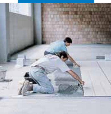
Verlegen von Feinsteinzeugplatten mit Granirapid-grau in einer Produktionshalle
