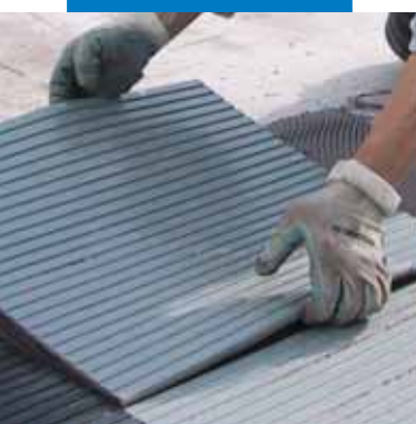
Verlegung von Gummi-Bodenbelagplatten mit Granirapid
