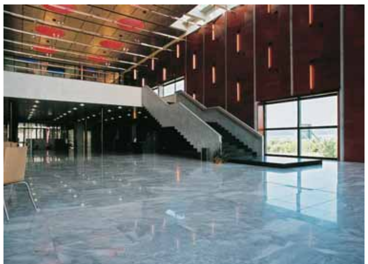
Naturwerksteinverlegung in der Eingangshalle des "Spielcasino Feuchtwangen" (Deutschland)
