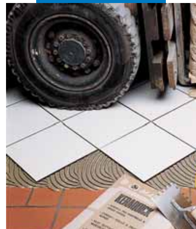
Neuverlegung von Bodenfliesen im Gewerbebereich
