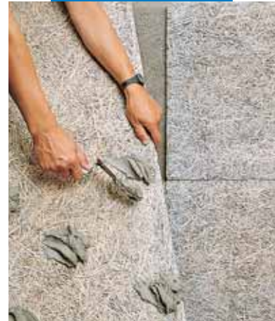
Verlegung von Dämmplatten im Punktklebeverfahren
