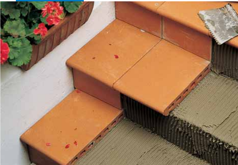
Verlegung von Tonziegelfliesen auf einer Treppenkonstruktion
