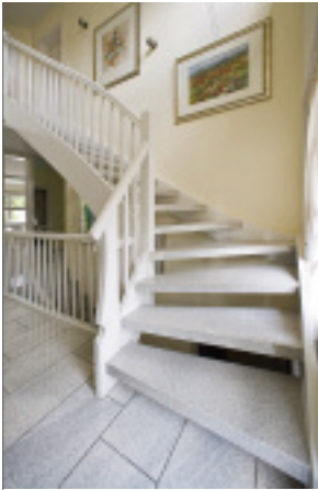
Treppenverkleidung mit Imperial White in 0,8 cm Stärke (R-Tech-System)
