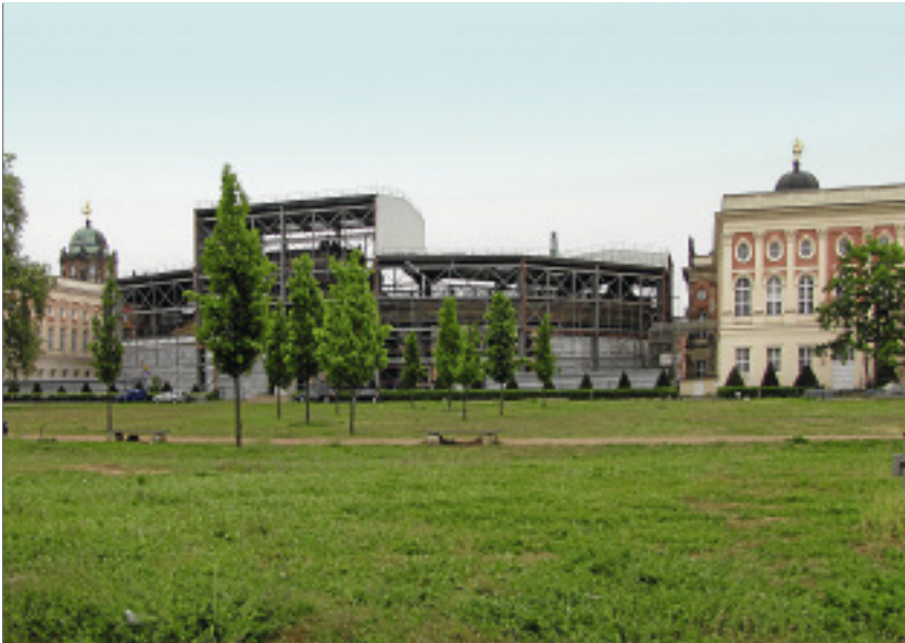
Eine Wetterschutzeinhausung umgibt die gesamte Kolonnade.
