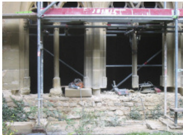
Um die neuen Mauerabdeckungsplatten unterschieben zu können, wurden die Mittelrippen aufwendig gesichert. Foto: Büro AeDis
