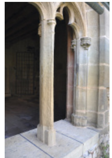
Neue Mauerabdeckung mit geschlammter und an der Basis erneuerten Rippe
