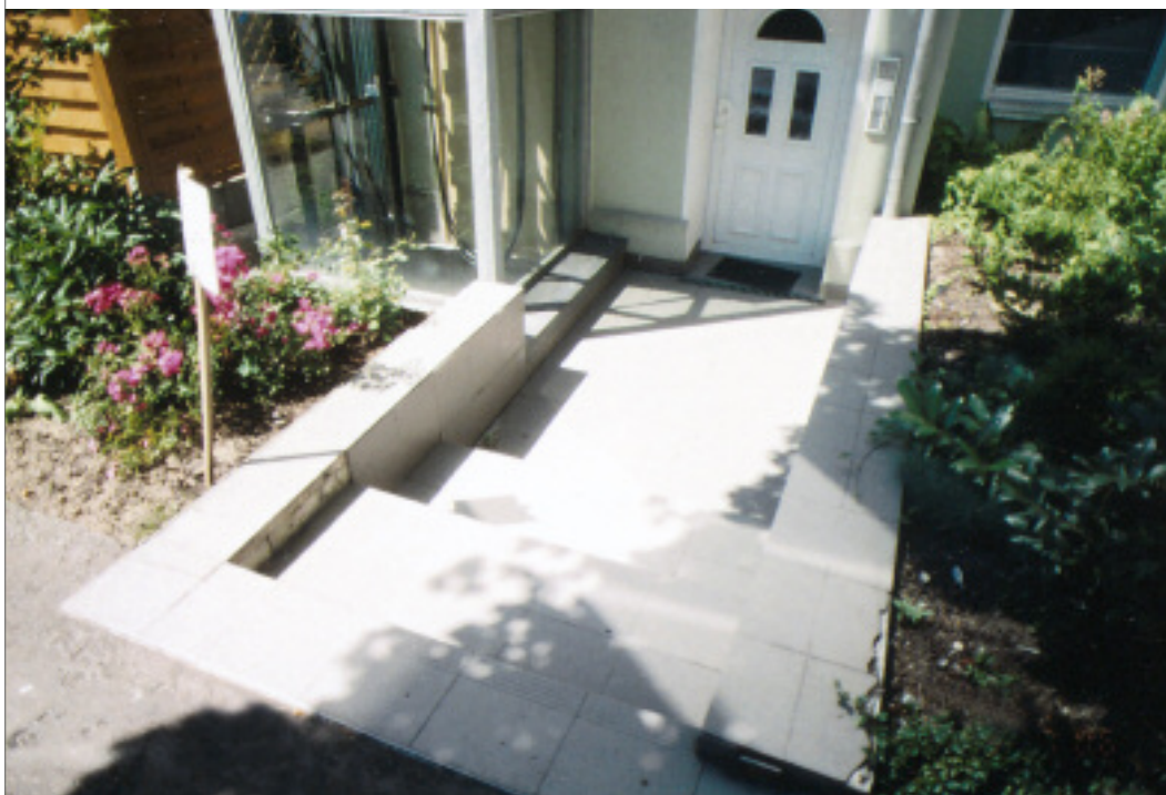
Die Treppe zur Haustür
