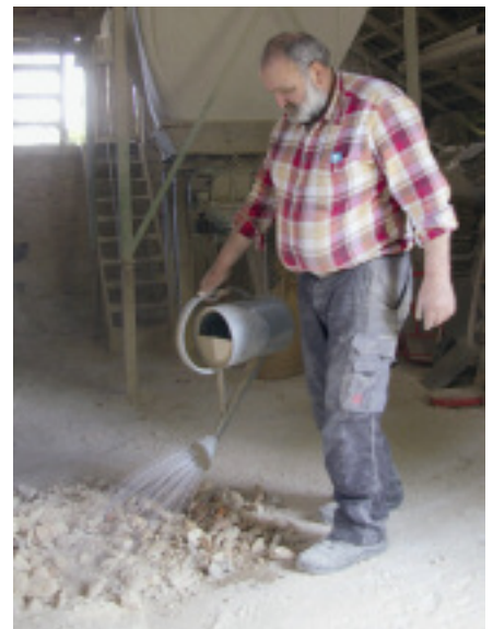
Ablöschen des gebrannten Kalks
