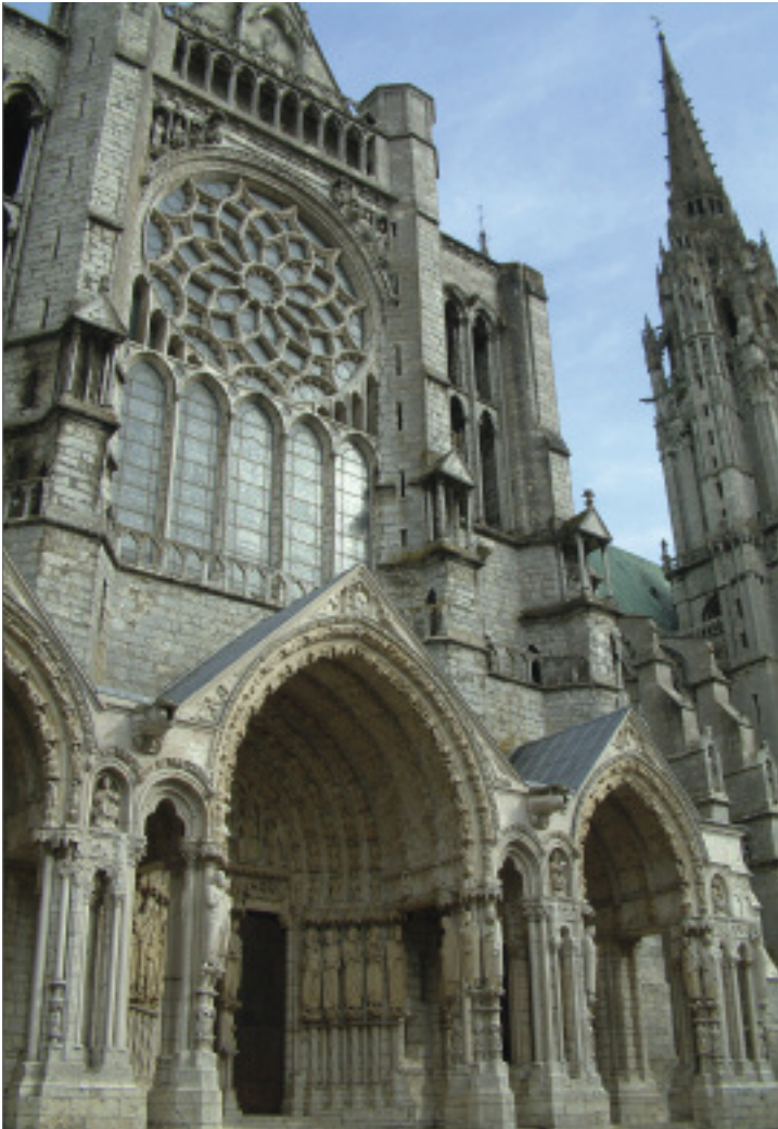
Die restaurierte Querhausfassade mit Nordportal und Nordrose
