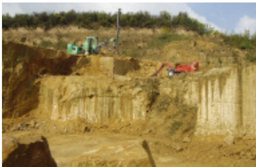
Die Firma Erich Seubert baut Sandsteine in eigenen Brüchen ab.
