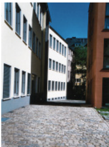
Die neuen Granitpflastersteine sind in den Farben und Formaten gemischt.
