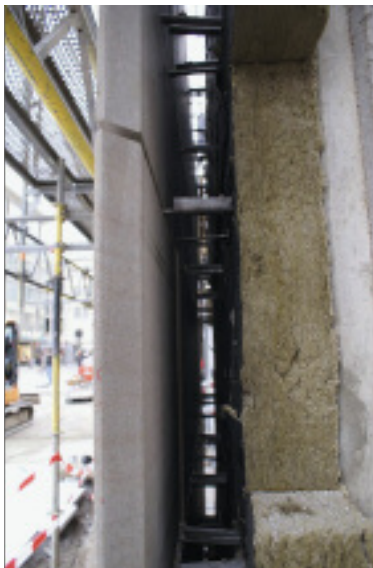
Vorgehängte, hinterlüftete Fassade mit Dämmung
