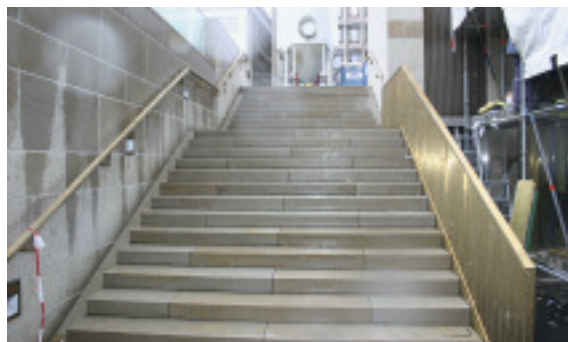
Treppe aus 62 massiven Blockstufen im Bauzustand
