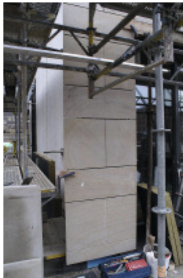
Während der Fassaden-Montage Fotos: Firma Grandi
