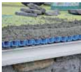
Unterkonstruktion aus der Spezialdrainage AquaDrain EK von Gutjahr
