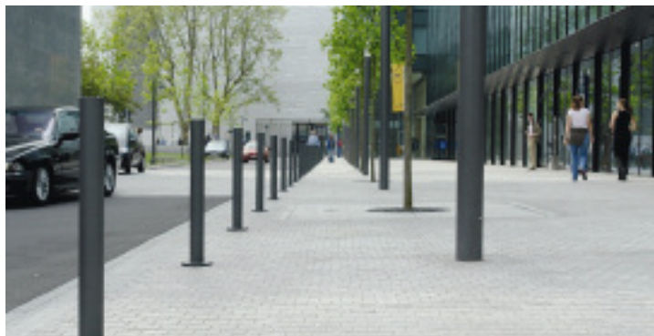
Von Immo Herbst ausgeführte Außenanlage der BHF-Bank an der Bockenheimer Landstraße in Frankfurt am Main
