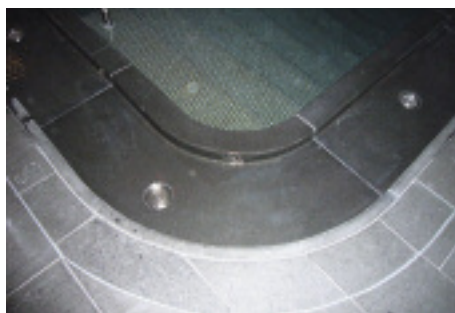
Rinnen-Eckelement gefertigt aus einem Granitblock
