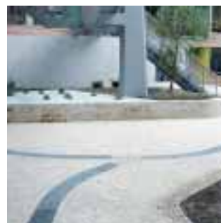
Blindenleitsystem aus schwarzen Olivinbasaltplatten
