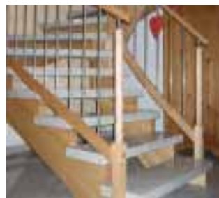
Treppe mit Herz: die Stein-Holz-Treppe von Rita und Hubert Keinath
