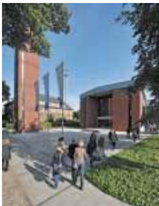
Die ehemalige Pfarrkirche St. Bonifatius in Münster wird heute als Verlagshaus genutzt.
