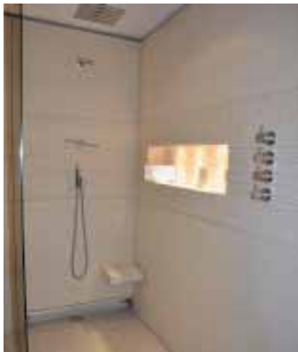
Bad mit der patentierten Duschtasse »Aqua 2« und dem von Ströhmann entwickelten Klappdeckel-Modell »Swing Flap« im Abfluss-Bereich; Glasbefestigung: »Keep-ups« ohne Silikonbefestigung an Wand und Boden
