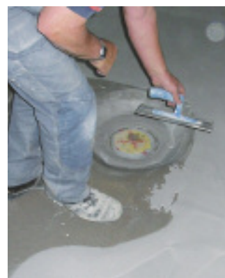
Abb. 8: Abdichtungsvorgang mit Sopro Dichtungsschlämme Flex 1-K
