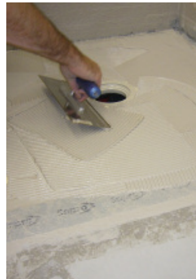
Abdichten einer Bodenfläche mit einer geeigneten Dichtschlämme
