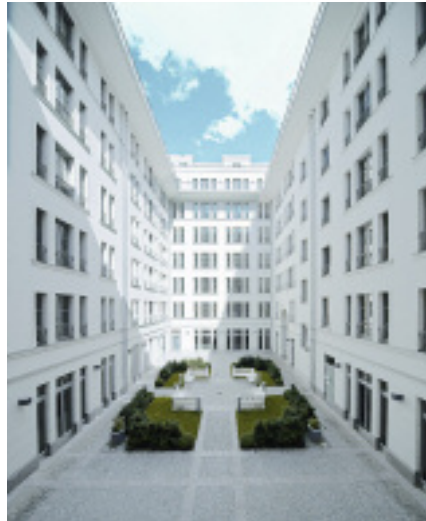
Hinterhof mit Belag aus Flossenbürger Granit und Pearl Anglais (Foto: Sto AG)
