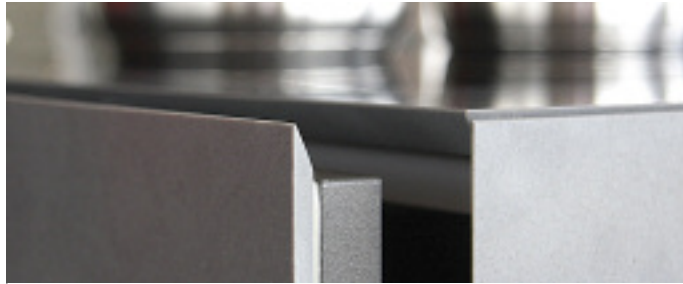
Möbelbekleidung aus Silestone® von Cosentino. Gehrungsschnitte mit Softkante (Bleistiftkante). Die Bekleidungselemente, einschließlich der elektrisch aus- und einfahrenden Fächer, ergeben exakte Schattenfugen. Foto: Steffen Würstl
