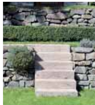
Blockstufen aus Travertin und Trockenmauern aus Muschelkalk verschönern jeden Garten. Foto: Firma
