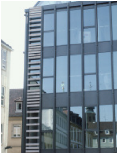
Die Lamellen aus Muschelkalk wurden Reihe für Reihe angebracht.
