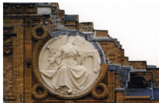
Berlin, Anhalter Bahnhof, Relief »Ingenieurwissenschaft« nach Restaurierung
