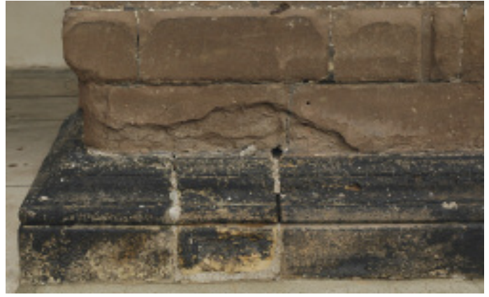
Typische Schalenbildung am stark saugenden Lettenkohlsandstein (oben); dichter Rätsandstein (unten)
