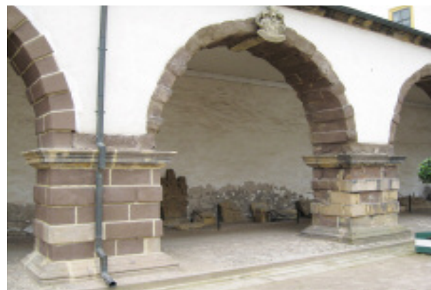
Restaurierter Pfeiler (I.) mit Vierungen aus FREUDENBACHER SANDSTEIN und SEEBERGER SANDSTEIN
