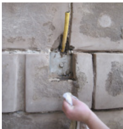
Steinergänzungen aus Acrylatmörtel und eingeklebter Maueranker an einem Pfeiler
