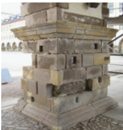
Pfeiler nach dem Ausarbeiten der Vierungen aus LAUTERBACHER SANDSTEIN
