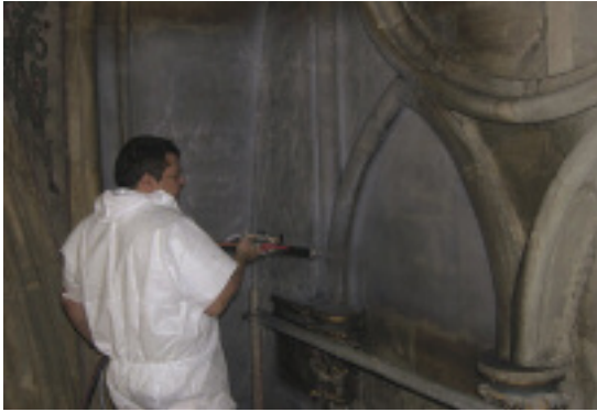
Die Reinigungskomresse aus einem Tonmineral und einem Füllstoff wird mit einer modifizierten Feinputzmaschine großflächig aufgetragen.
