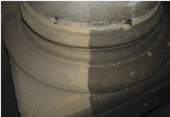
Das Reinigungsergebnis nach dem Mikropartikelstrahlverfahren mit 0,3 bar Arbeitsdruck
