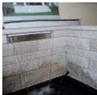
Mauerwerk aus dem istrischen Kalkstein KANFANAR (GIALLO D' ISTRIA)
