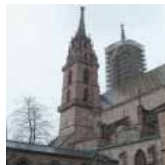
Der Georgsturm am Basler Münster wird derzeit restauriert und konserviert.
