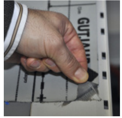
Selbstklebende Abdichtungsbänder sorgen für sichere Anschlüsse.
