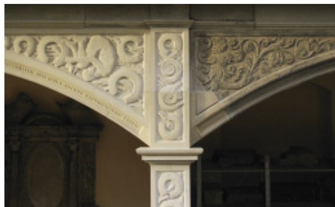
Übergang von Bogen Nr. 4 zum historischen Bogen Nr. 5
