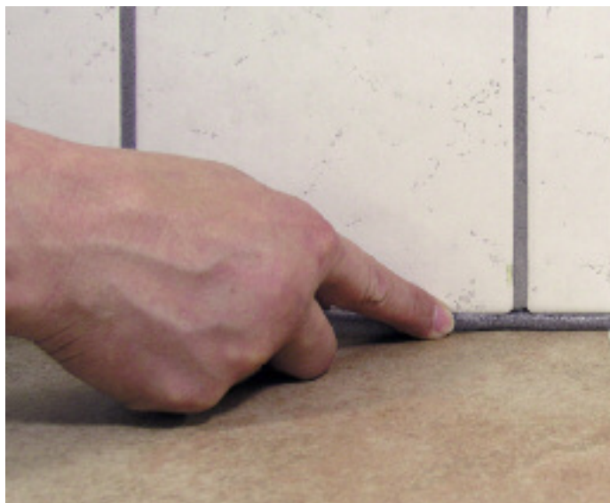
Hinterfüllen der Fuge mit einer Rundschnur
