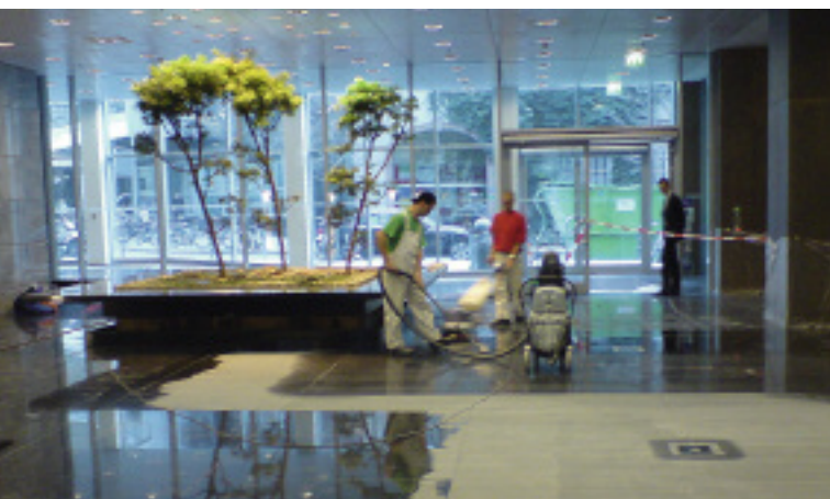
Durch Schleifen können Böden nachhaltig aufgewertet werden: Sanierung eines Bodenbelags aus STAR GALAXY in Frankfurt a. M.
