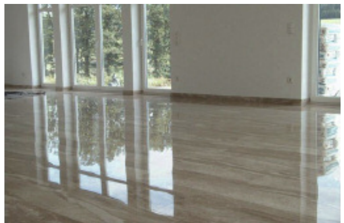
Frisch geschliffen: fertig bearbeiteter Bodenbelag
