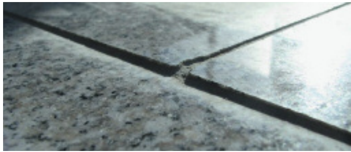
Überzähne und andere Mängel lassen sich durch Schleifen beseitigen
