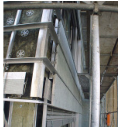
IBT-T-Konsole: Anwendungsbeispiel thermisch getrennter Konsolen aus dem Jahr 2000 und realisiertes Brüstungsdetail der Elvia Versicherung
