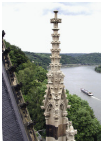
Die Restaurierungsarbeiten der Apollinariskirche in Remagen wurden von MAYKO mit eigener Basaltlava ausgeführt
