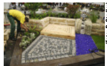
Fast fertig: Pflasterbelag und Natursteinmauerwerk der Landschaftsgärtner
