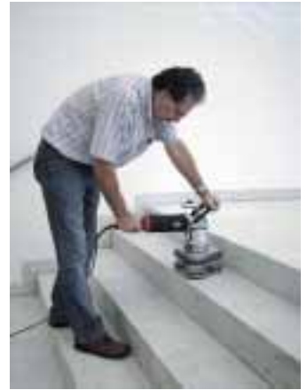
Steinbodensanierung im Museum Abteiberg mit den Dreischiebenmaschinen »Hattrick« und »Trimax«
