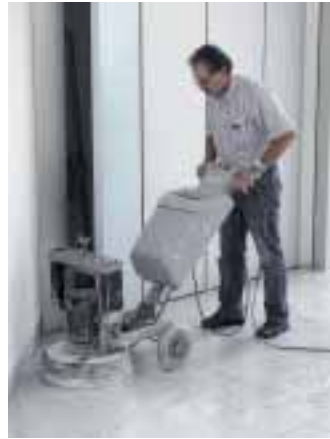
Steinbodensanierung im Museum Abteiberg mit den Dreischiebenmaschinen »Hattrick« und »Trimax«
