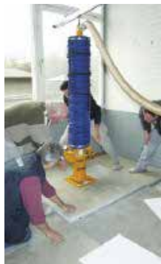
Bei der Verleges Schulung in Korb
