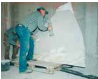
Abb. 1: Aufziehen der Kontaktschicht bei Anwendung des Buttering-Verfahrens
