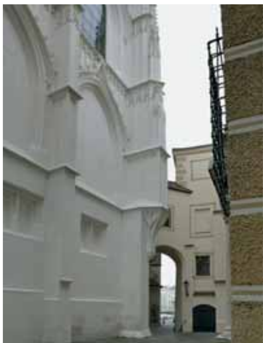
Abb. 10: Ansicht des Pfeilers nach Abschluss der Restaurierungsarbeiten einschließlich der abschließenden Kalkfassung
