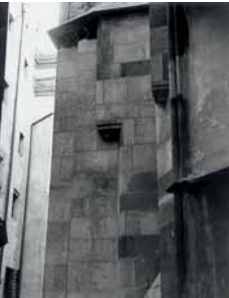
Abb. 3: Die veränderte Situation nach der Unterbauung des Pfeilers; die Blickrichtung ist die gleiche wie in Abb. 1.
