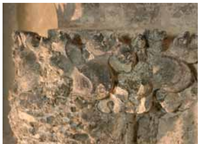
Abb. 7: Detailansicht des vollständig einbetonierte Konsolknaufs. Eine besondere restauratorische Herausforderung war die Entfernung des Betons aus den Hinterschnidungen und den zahlreichen Durchbrüchen des fragilen Blattwerks.
