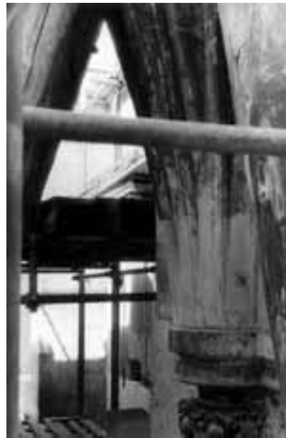
Abb. 4: Lediglich im Archiv der Staatlichen Dombauhütte waren noch Aufnahmen der Pfeilerkonsole zu finden.
