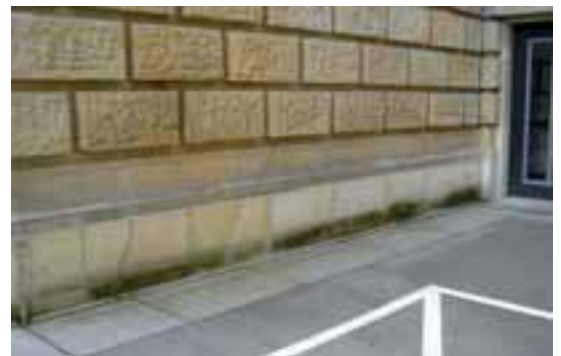
Innenhof vor der Reinigung
