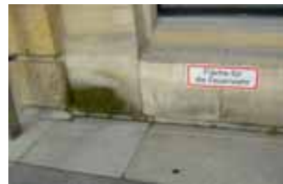
Vor der Reinigung: starker Bewuchs mit Moosen und Algen
