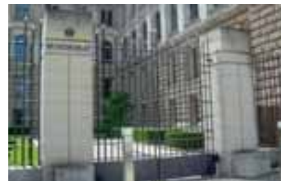
Pfeiler vor der Reinigung
