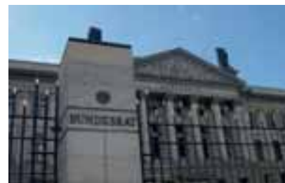
Pfeiler nach der Aufstockung
