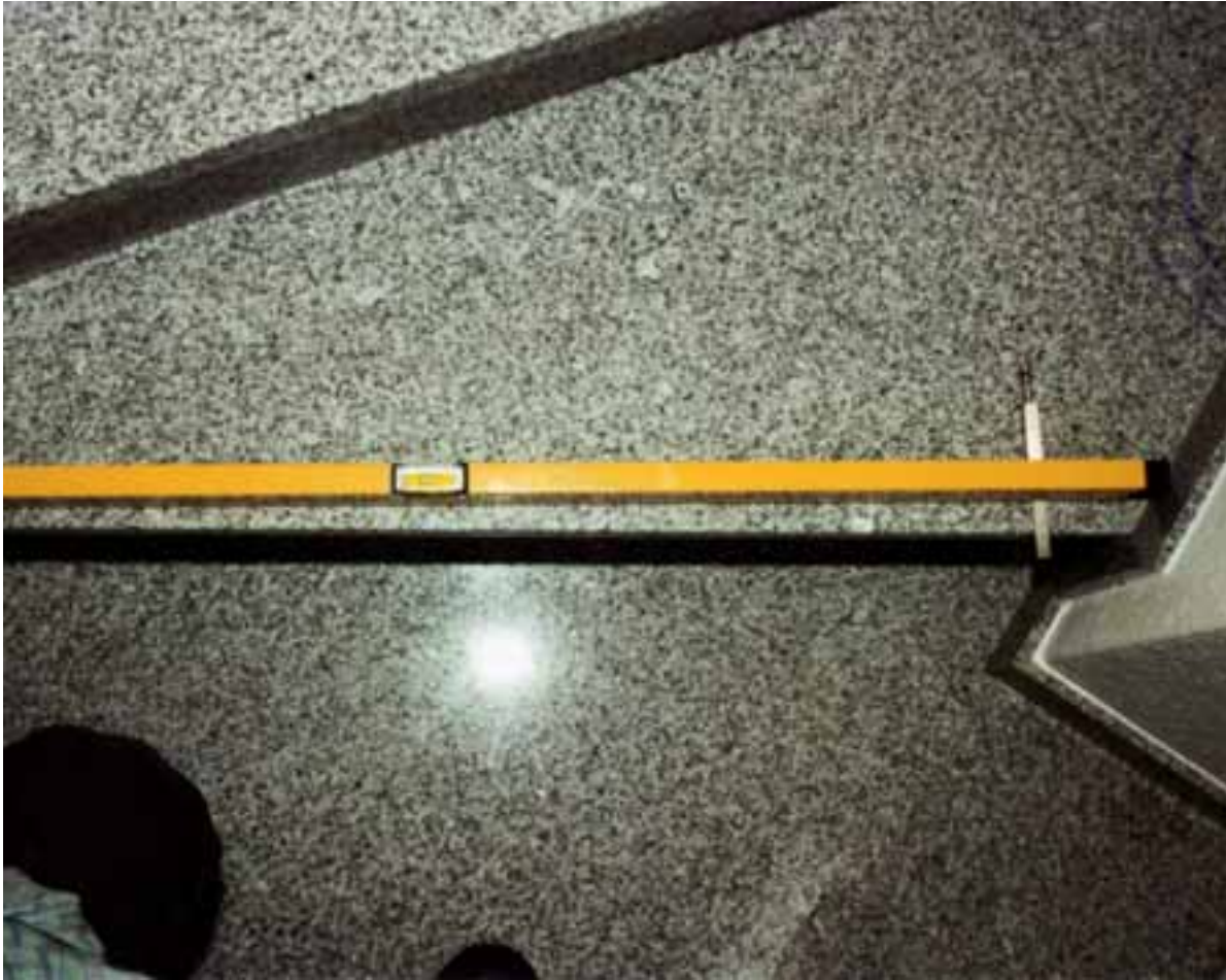
Gegengefälle in Stufenlänge und Gehrichtung
