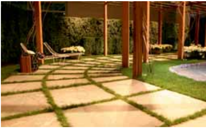
Showgarten der Gartenbaufirma Zingg AG: Mit Rasen verfugeter Belag aus BERNARDINO-Augengneis unter einem Laubengang aus Zedernholz. Plattenhersteller: Bärlocher AG
