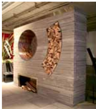
Showgarten der Living Association: Die Diepold & Zraggen Gartenbau AG ( www.dzgartenbau.ch ) machte u. a. mit dieser Feuerstelle aus geschichteten VALSER QUARZIT-Platten auf sich aufmerksam.
