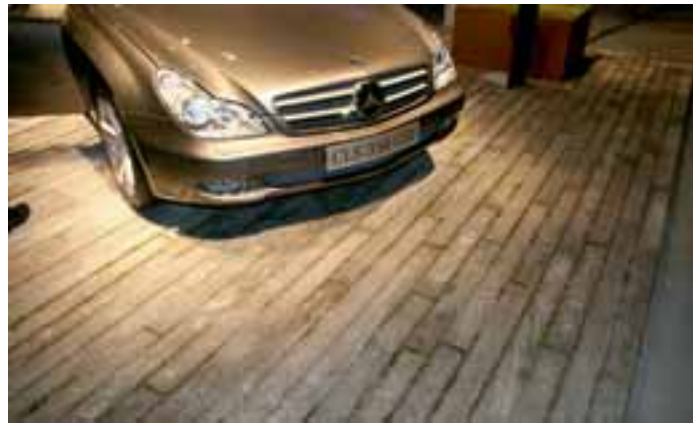
Ebenfalls aus BERNARDINO-Augengneis: Von der Winkler & Richard Naturgärten entwickelter neuer Bodenbelag aus bruchrauen Steinriemen; Hersteller: Bärlocher AG
