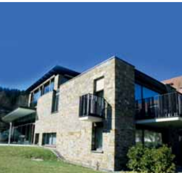
STAINZER HARTGNEIS am Kur- und Sporthotel Lauterbach (Ausführende Firma: Kienzle Naturstein GmbH, Altensteig)
