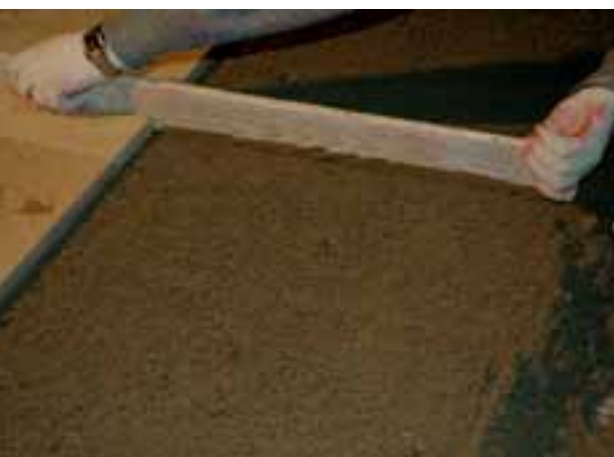
Das Mörtelbett wird mit einer Lehre überhöht abgezogen. Das Mörtelbett wird weggesteuert verdichtet. So lässt sich hohlraumfrei verlegen.
