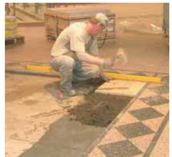
Verlegen von Kreissegmenten in ein Mörtelbett, hergestellt mit dem Bindemittel Mapecem in Verbindung mit der Haftbrücke Mapestone 3
