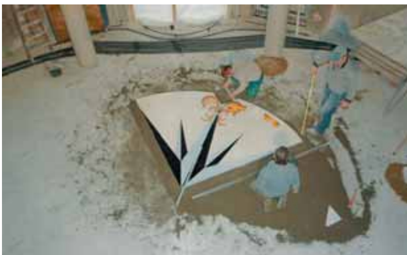
Verlegen von Kreissegmenten in ein Mörtelbett, hergestellt mit dem Bindemittel Mapecem in Verbindung mit der Haftbrücke Mapestone 3
