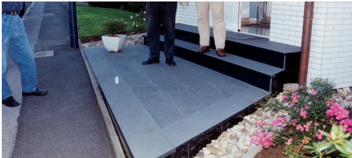
Außentreppe aus NERO ASSULUTO mit geringem Gefälle (1,5%)
